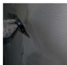
5. Zatapiać siatkę i szpachlowanie
