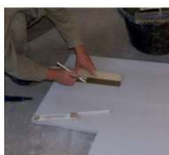
1. Znakowanie i docinanie płyt
