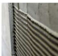
2. Rozprowadzenie kleju na ścianie
